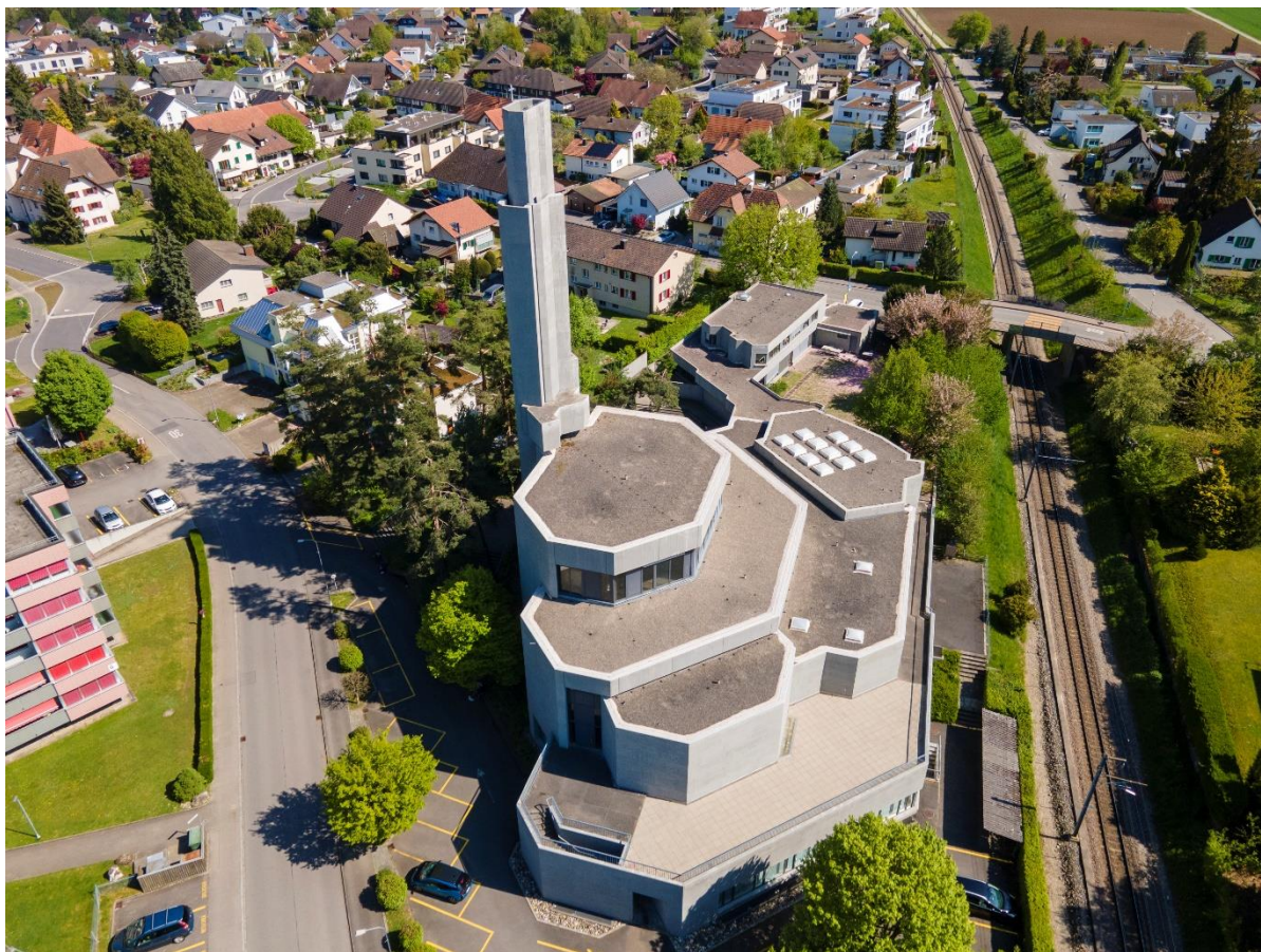
Abbildung 2: Das terrassierte Kirchengebäude mit angebautem Pfarrhaus
